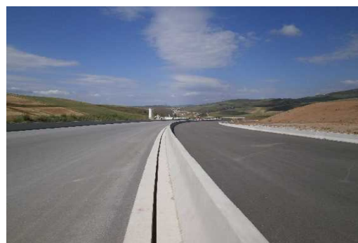
(完成間近だった高速道路)
